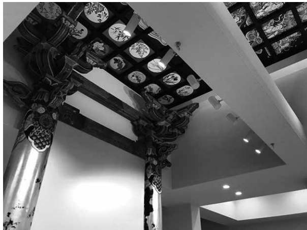
新本堂に活かされた旧本堂の台高柱
