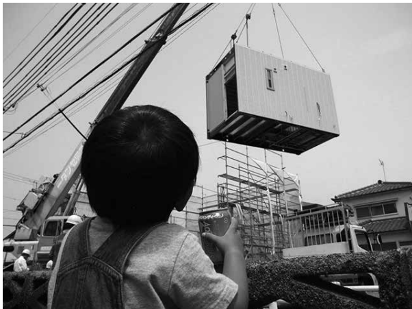
85%の工程が工場で作られるため耐久性の高い建物になる
